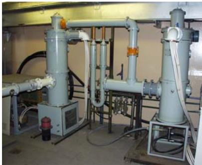
Рис. 6. Двухкаскадный генератор на триодах ГИ-50А.
