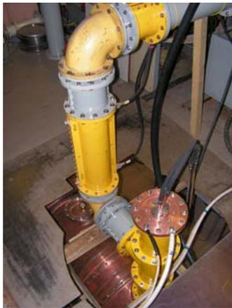
Рис. 5. Коаксиальный фидер (вверху) с направленным ответвителем (по центру) и вводом мощности (внизу).
