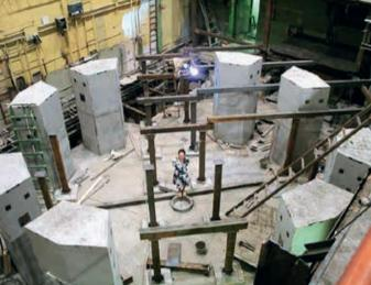
**Рис. 3.** Слева: завершается разборка основания ВЭПП-2М, залиты первые две колонны под магниты ВЭПП-2000, 14.05.2001. Справа: монтаж опор для детекторов и фальшпола, 17.07.2001
