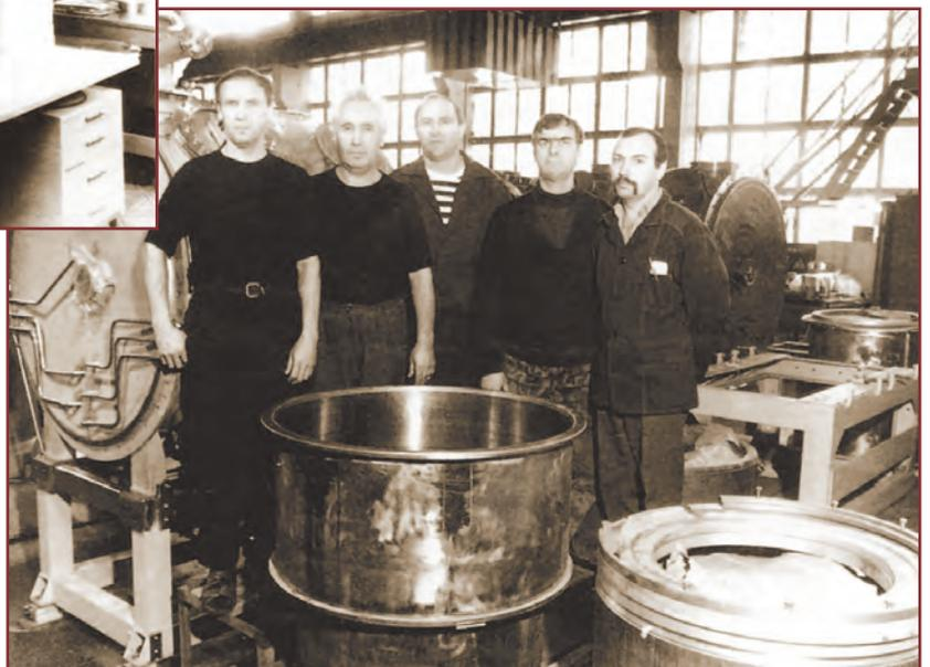
ИЯФ известен высокой культурой разработки и производства резонаторов — важной части ускорителей. И в этом немалая заслуга ЭП-1, в частности, команды А. М. Гезикова. Идет сборка очередного резонатора. Слева направо: В. А. Мойшев, А. М. Гезиков, Г. Г. Черданцев, А. Н. Костромитинов, С. П. Трунин
