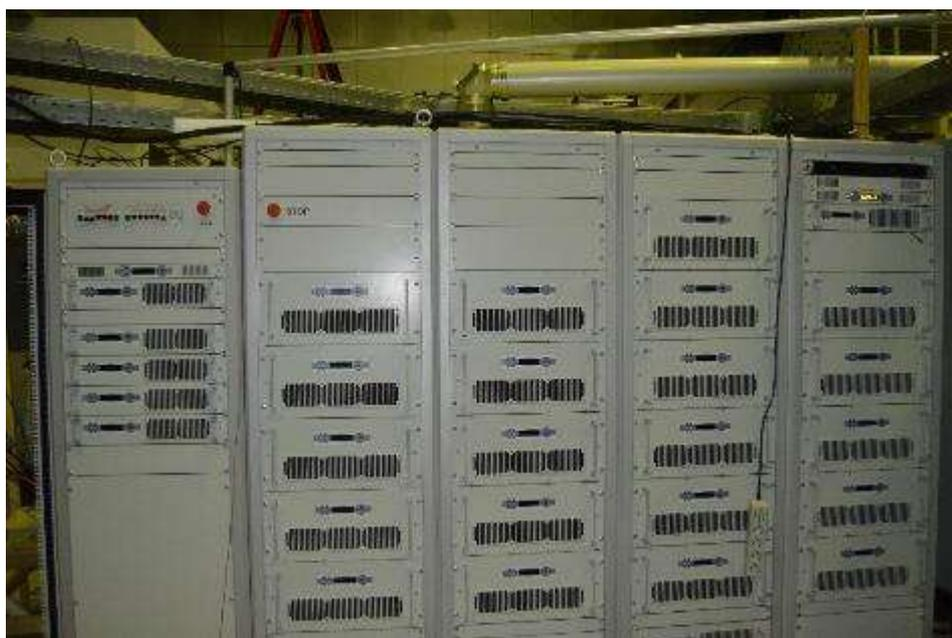
Рисунок 6.6 - ВЧ усилители для питания пушки и резонатора группировки
